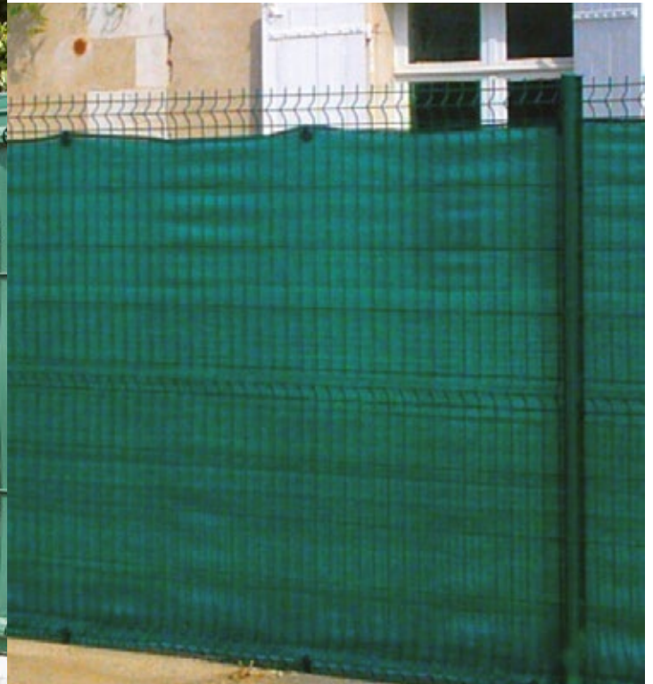
Clôtures non-conformes : lames occultantes en PVC et tissu tendu
