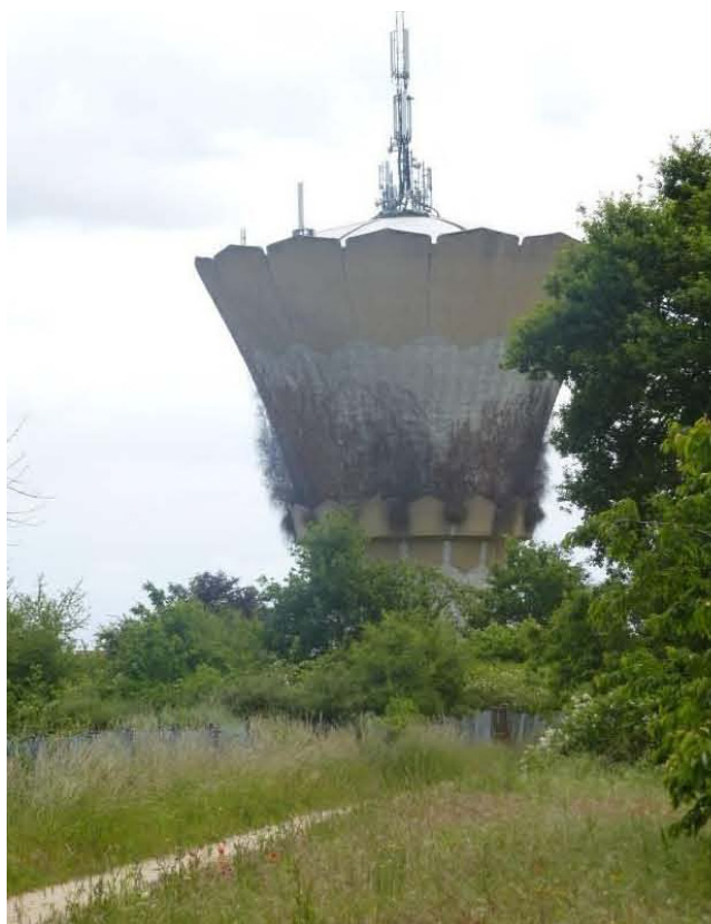
Photo 22 : Château d'eau communal
