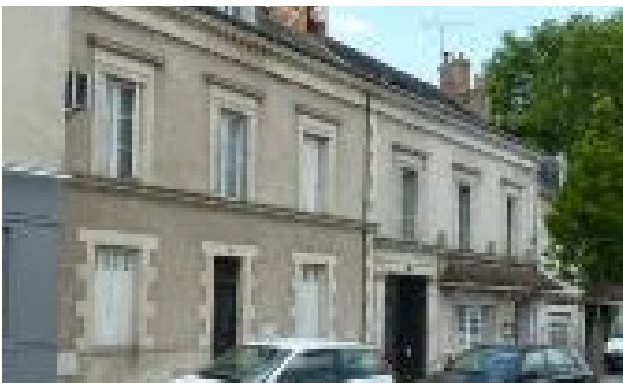
Bâtiment au 30 rue Marcel Belot
