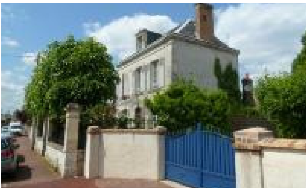
Bâtiment au 417 rue de la Source
