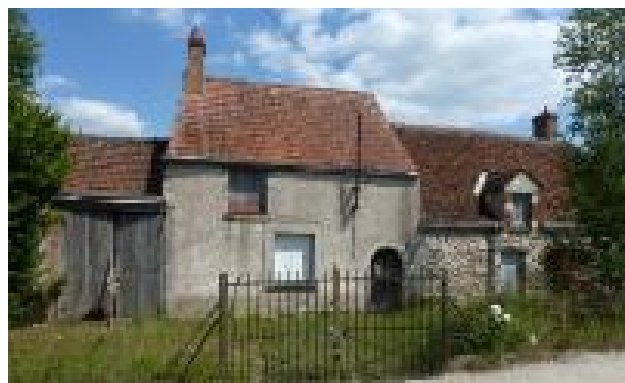
Bâtiment Rue de Clatz
