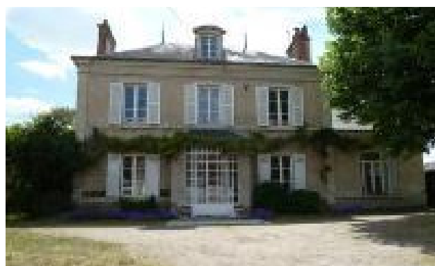
Bâtiment au 398 rue de la Source
