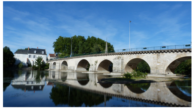
Encorbellement sur le pont Maréchal Leclerc
