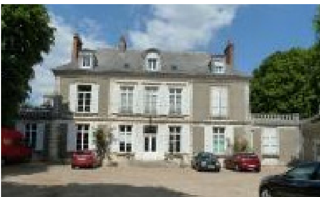
Bâtiment au 619 rue de la Source
